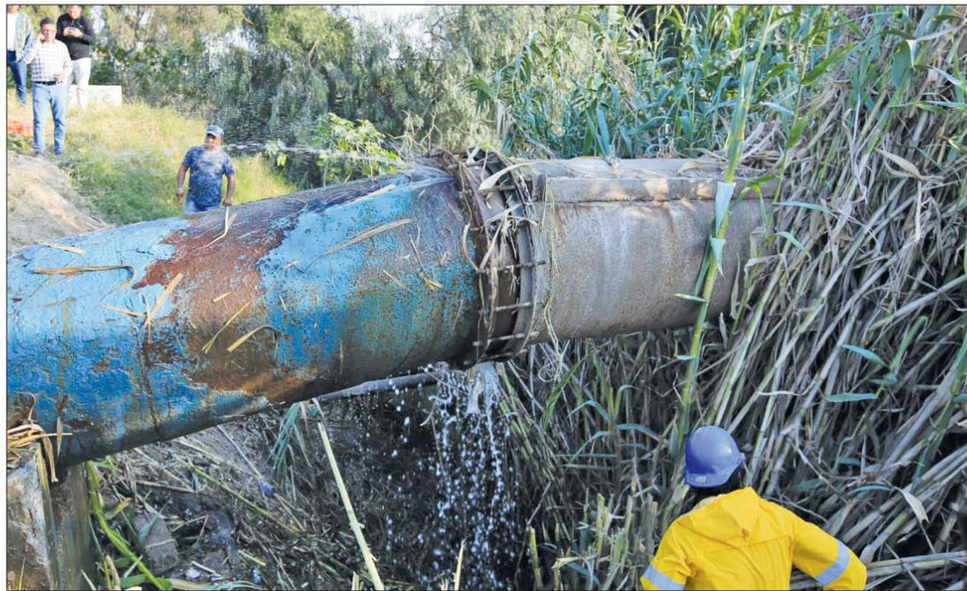
▲ Dos megafugas de agua potable fueron detectadas en la línea de distribución hacia la Quinta Zona de Ecatepec, cuyo líquido caía y se desperdiciaba en el canal La Draga, a la altura de la colonia Valle de Ecatepec CTM 13. El gobierno municipal informó que se trata de una tubería principal de 36 pulgadas por la que durante años
